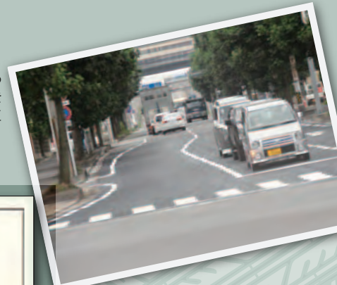
廃タイヤを有効活用する 「アスファルトラバー」舗装路を 白河市に施工
