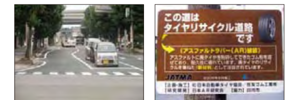
白河市に施工したアスファルトラバー舗装路
